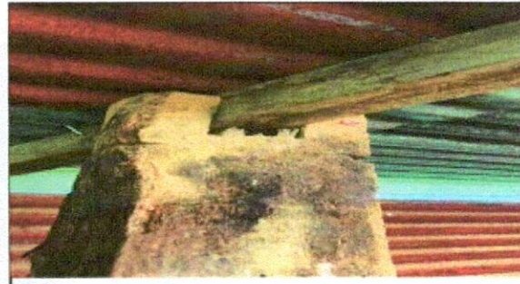
Foto 4: Cubierta de lámina
