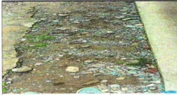
Foto 1: Sustrucción de piso
