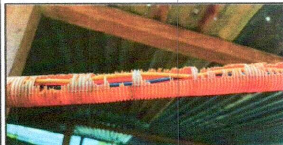
Foto 5: Reparación de sistema eléctrico
