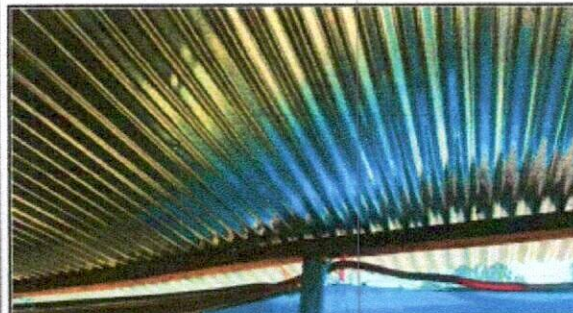
Foto 3: Cubierta de lámina
