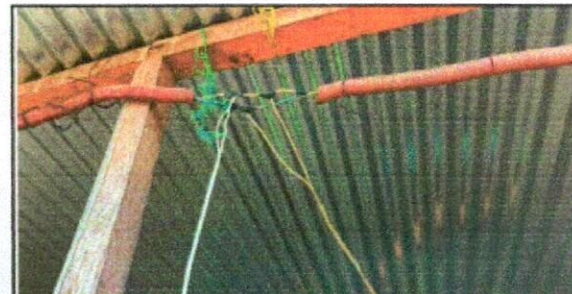
Foto 6: Reparación de sistema eléctrico
