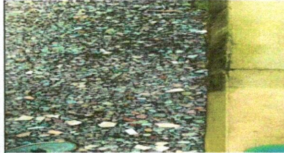
Foto 2: Sustrucción de piso
